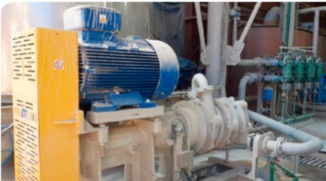
主要干预措施包括在定量泵电机中安装逆变器，并取消液压控制单元中的变量泵（或者，现有的定量泵控制单元可配备逆变器）。
